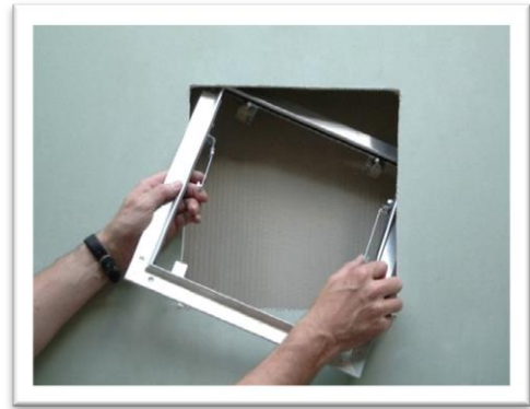
2. Türblatt aushängen, Rahmen diagonal durch den Ausschnitt führen und auflegen
