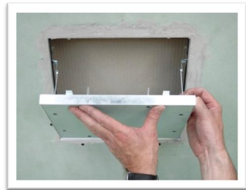
6. Klappen einhängen, sichern und verschließen
