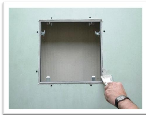
5. Decke und Klappe einzeln verspachteln
